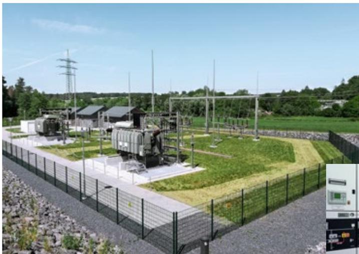
Die Umspannanlage in Selters ist die modernste der enm. Hier werden 110 000 Volt in 20 000 Volt umgewandelt und der Stromfluss für 25 000 Menschen sowie die Industriebetriebe gesteuert.
