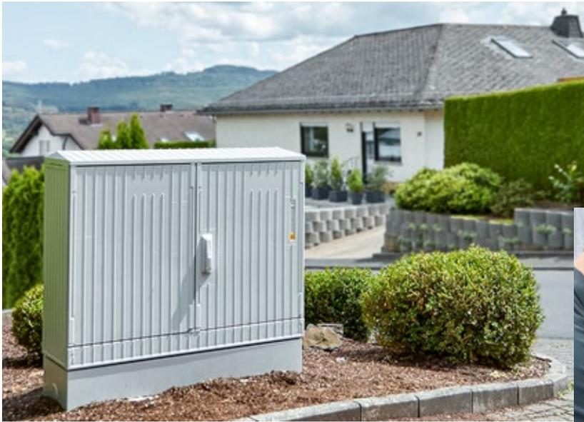
Auch in diesem Kabelverteilerschrank in Kadenbach sind Sensoren für die Weitbereichsregelung verbaut.
