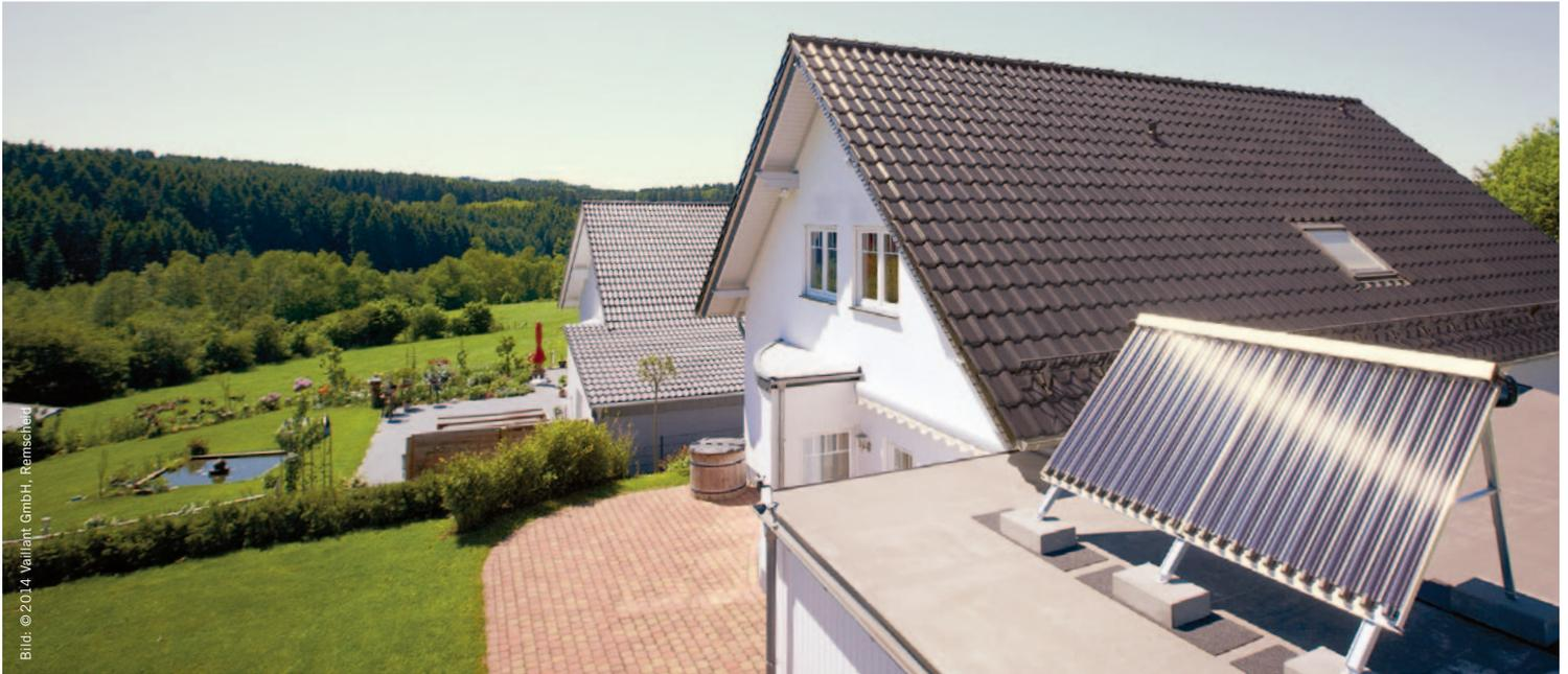
Noch wirkungsvoller als eine reine Erdgas-Brennwertheizung ist die Kombination mit einer thermischen Solaranlage. Die zusätzliche Energie aus Solarkollektoren wird zur Warmwasserbereitung und/oder zur Unterstützung der Heizungsanlage eingesetzt. Wenn die Anlage richtig dimensioniert ist, deckt sie noch einmal bis zu 20 Prozent des jährlichen Energiebedarfs für die Heizung und bis zu 60 Prozent des Energiebedarfs für die Warmwasserbereitung ab. Ressourcenschonend und ohne schädliche Emissionen.
