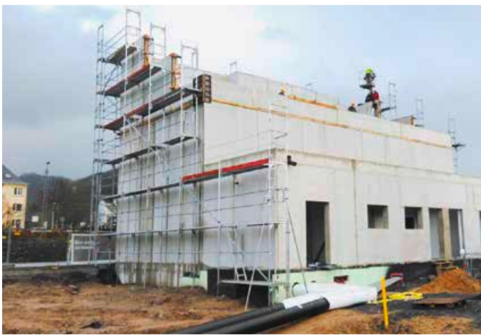
In der evm-eigenen Technikzentrale schlägt das Herz des neuen Rheinquartiers.
