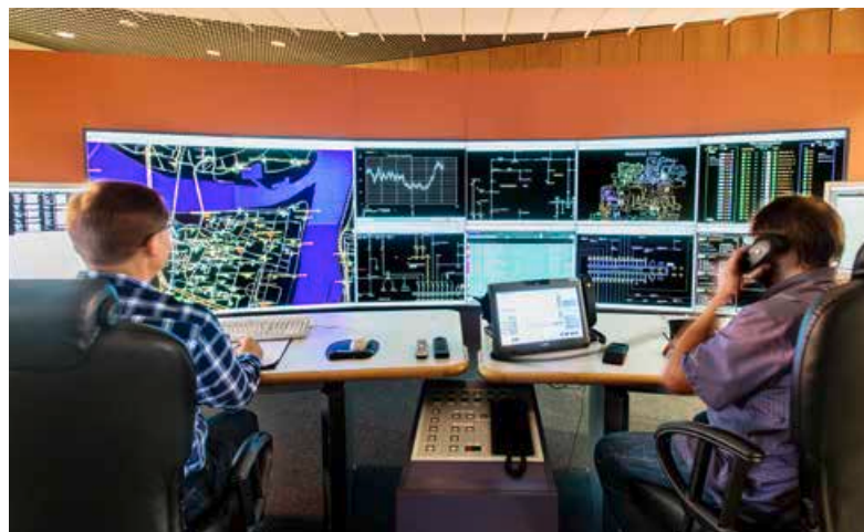
Das Herz der enm: die Netzleitstelle. Insgesamt kümmern sich 519 Mitarbeiter der enm um die Ertüchtigung und Sicherheit der Strom- und Gasnetze.
