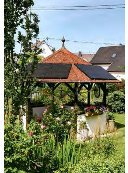
Mini-Photovoltaikanlagen sind flexibel einsetzbar.
