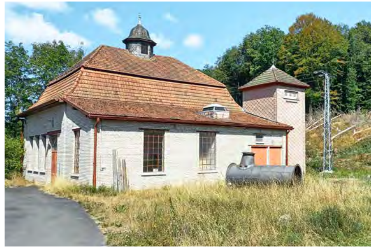
In diesem Maschinenhaus trifft das Wasser der Kleinen Nister auf die Wasserturbinen. Zuvor durchströmt es eine Druckrohrleitung mit einer Fallhöhe von rund 40 Metern. Eine Übersicht mit den wichtigsten Etappen im Oberwasserkanal zeigt die Grafik.
