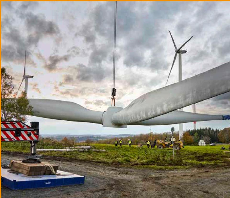
**Kraftakt:** Ein Großkran hievte den Rotor mit einem Durchmesser von 77 Metern auf den Boden.
