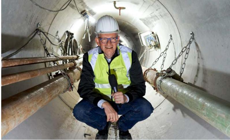
mehreren Bodenproben ein spezielles Bohrfahren: das sogenannte „Microtunneling“. Dafür ließen sie eine riesige Tunnelbohrmaschine in die Startgrube herab. Deren Bohrkopf, getauft auf den Namen „Viola“, bahnte sich dann Meter für Meter den Weg durchs Erdreich. Hinter Viola wurden sukzessive Betonfertigteil-Rohrsegmente eingezogen. Immer, wenn wieder genug Platz war, wurde ein Stück Rohr nachgeschoben, um den lockeren Untergrund zu stützen. So entstand nach und nach der komplette Tunnel.
