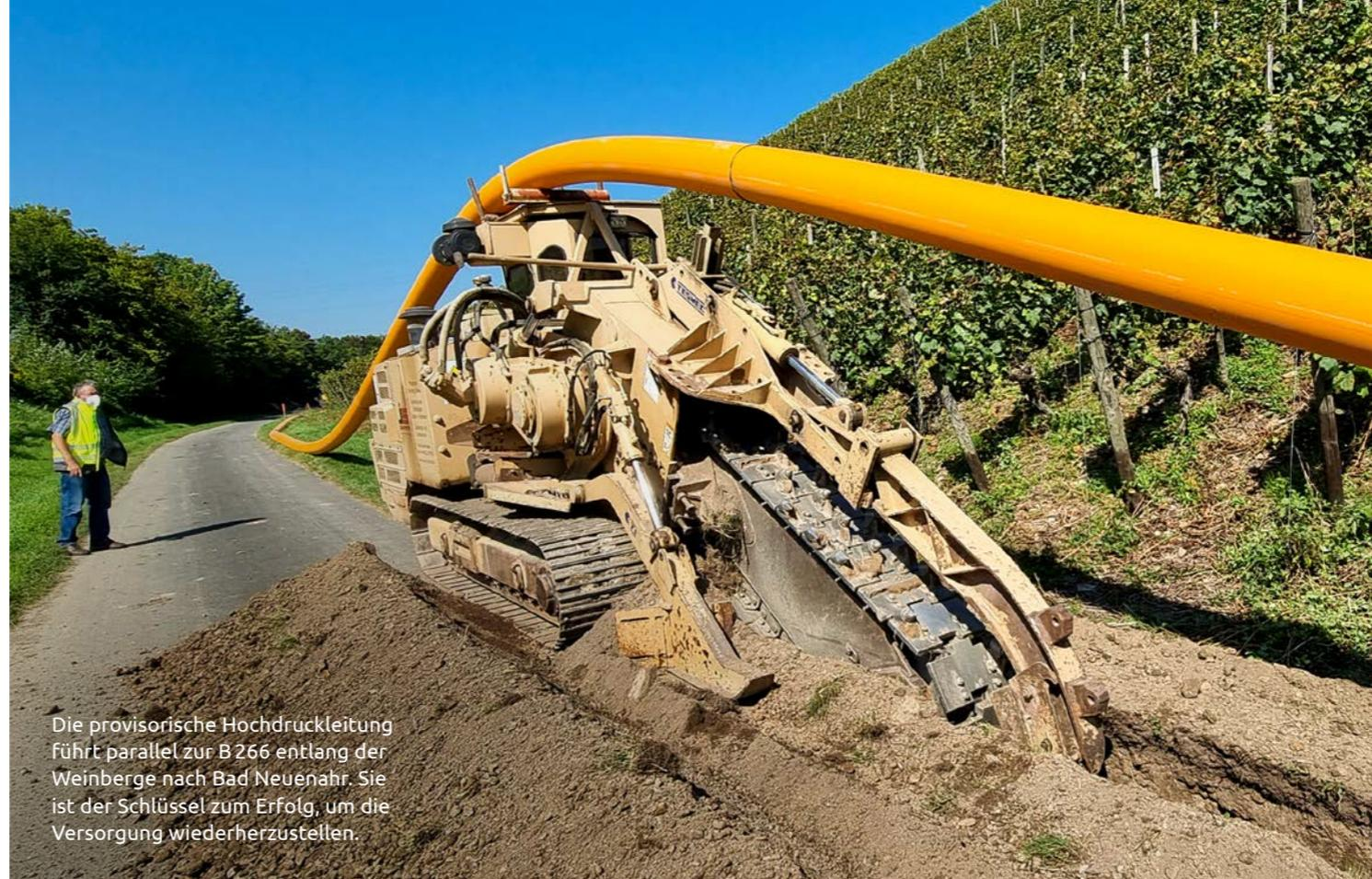
Die provisorische Hochdruckleitung führt parallel zur B 266 entlang der Weinberge nach Bad Neuenahr. Sie ist der Schlüssel zum Erfolg, um die Versorgung wiederherzustellen.
