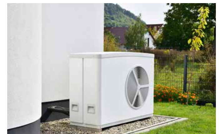
Eine Luft-Wasser-Wärmepumpe lohnt sich besonders in Neubauten mit hohem Dämmstandard.
