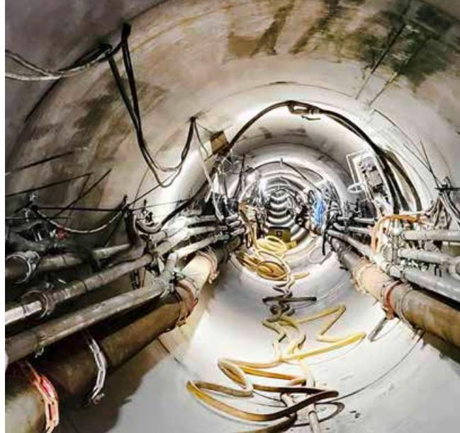
Riesenröhre unter dem Rhein: Der sogenannte Düker nimmt neben der neuen Trinkwasserleitung auch Kommunikations- und Stromkabel auf.
